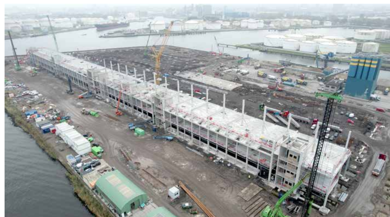
Uniek is dat aan de noordzijde van het gebouw al flink gebouwd wordt, terwijl de zuidzijde zich nog in de ontwerpfase bevindt.
