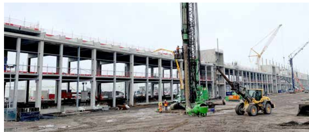
De prefab betonelementen worden tijdelijk opgeslagen in de Amsterdamse haven en just-in-time geleverd. Hierdoor kan de montage onverminderd doorgaan.
