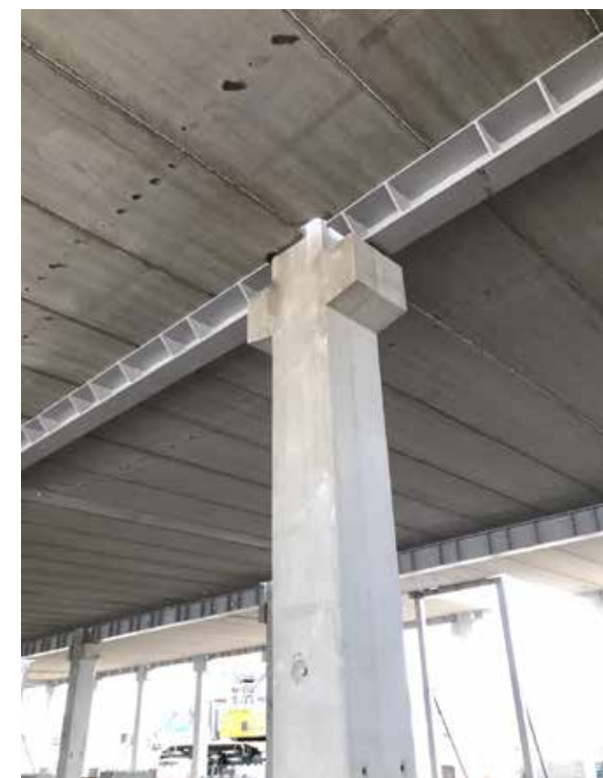
Prefab betonnen balken en vloeren.
