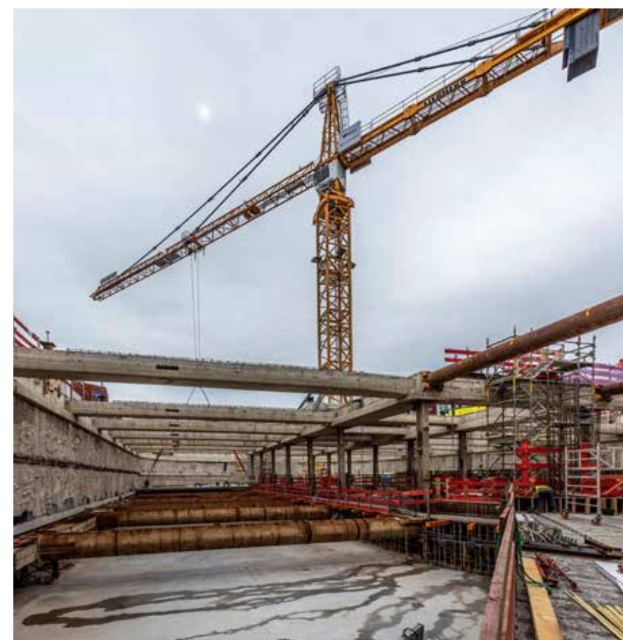
Het betonnen en stalen stempelraam. (Beeld: Buro JP)
